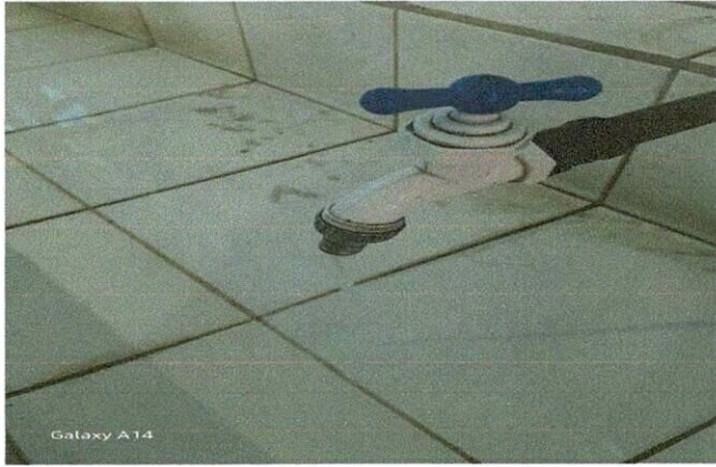
Foto 1: MEJORAMIENTO DE ÁREA DE SERVICIOS SANITARIOS
