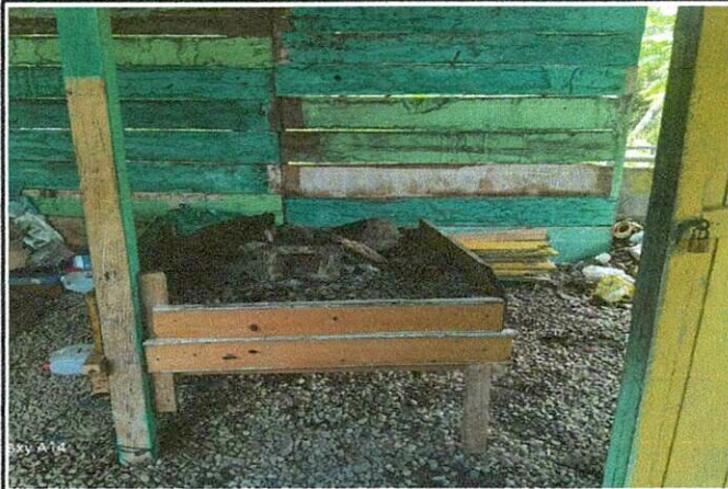
Foto 3: REPARACIÓN O SUSTITUCIÓN DE MÓDULO DE COCINA
